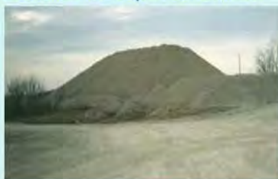
Érosion des piles/haldes
